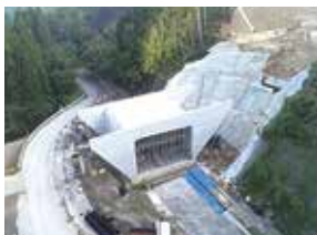
工事現場状況②
