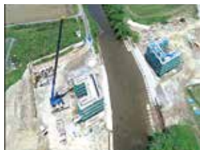
工事現場状況①
